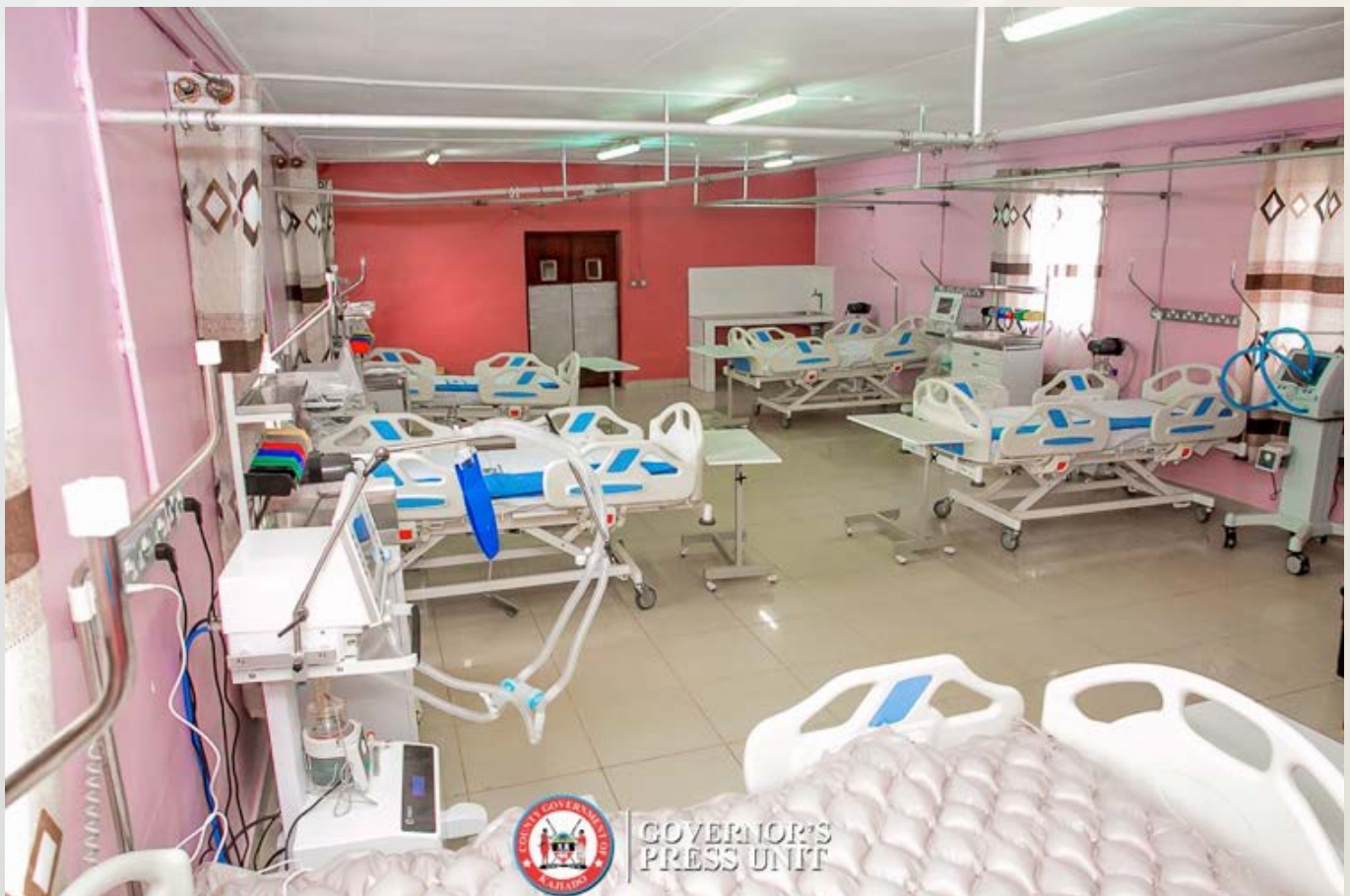
Kajiado County ICU Unit
